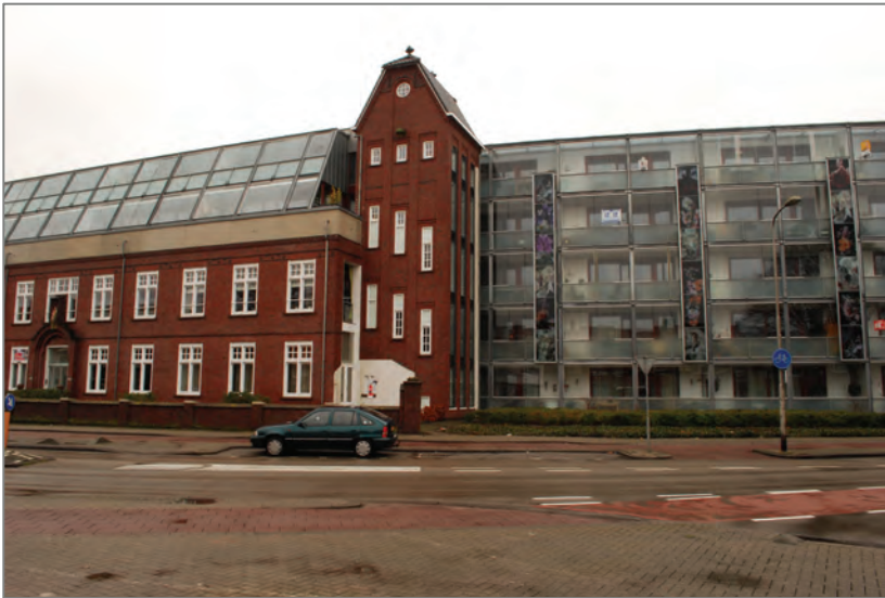
Wooncomplex Ave Maria. Alleen de rode gevel is bewaard gebleven
